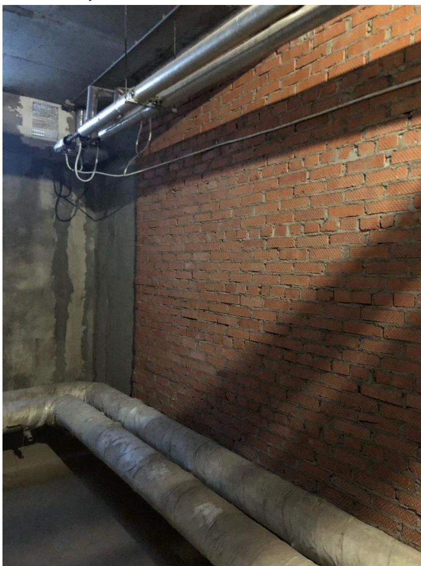
Фото 1 – Общий вид обследуемого участка
