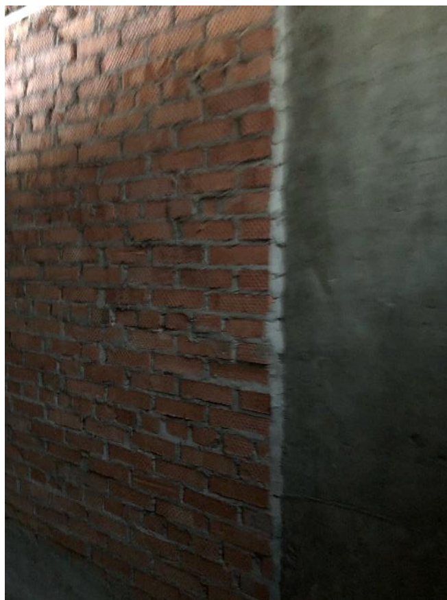
Фото 3 – Общий вид узла примыкания участка стены к ж/б колонне каркаса
