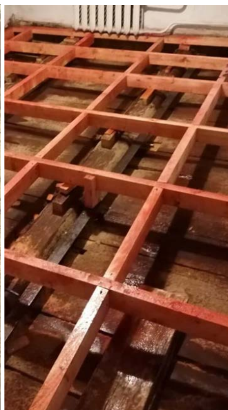
Фото 12,13. Усиление балок швеллером № 20У, пропитка деревянных конструкций антисептиком и антипожарным составом (комната 12,2 кв.м)
