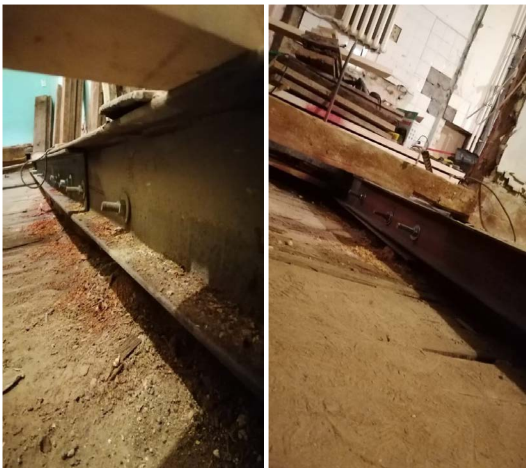
Фото 10,11. Усиление балок швеллером № 20У (комната 12,2 кв.м)
