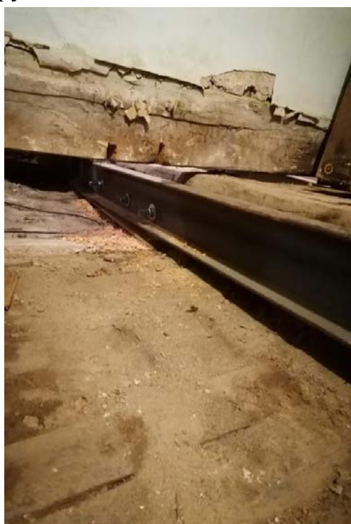
Фото 14,15. Усиление балок швеллером № 20У с опиранием 300 мм на стену (комната 12,2 кв.м)
