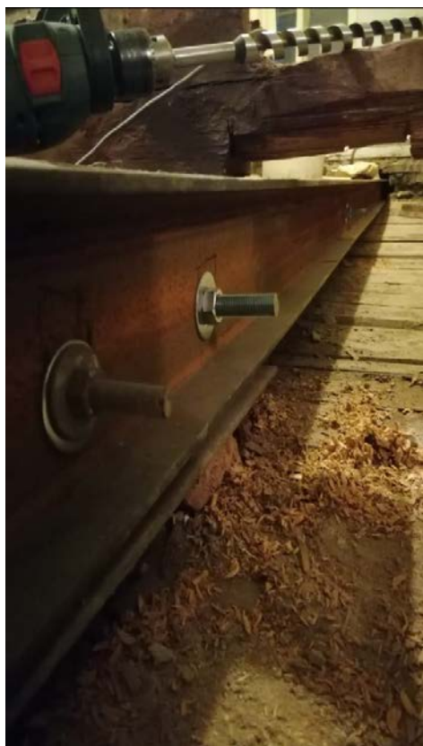
Фото 12,13. Усиление балок швеллером № 20У, пропитка деревянных конструкций антисептиком и антипожарным составом (комната 12,2 кв.м)
