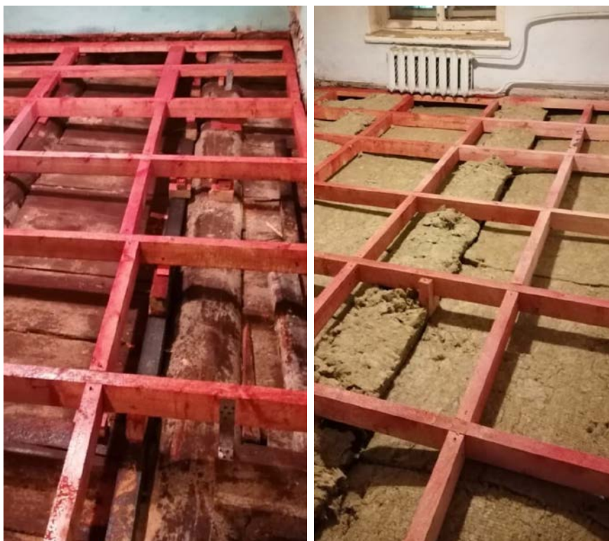
Фото 16,17. Пропитка деревянных конструкций антисептиком и антипожарным составом, устройство минеральной ваты (комната 12,2 кв.м)
