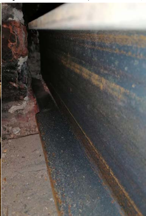
Фото 14,15. Усиление балок швеллером № 20У с опиранием 300 мм на стену (комната 12,2 кв.м)
