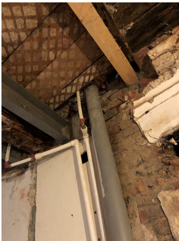
Фото 9. Перекрытие в квартире (потолок) (коридор)
