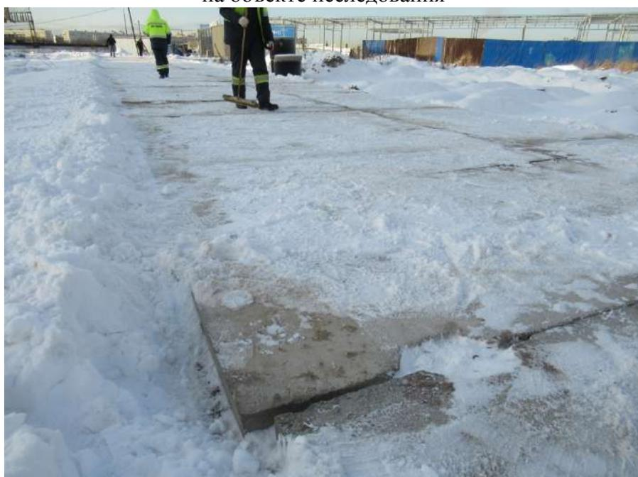
**Фото № 26.** Смещение расположения смежных дорожных плит сборных цементобетонных покрытий, уложенных на объекте исследования
