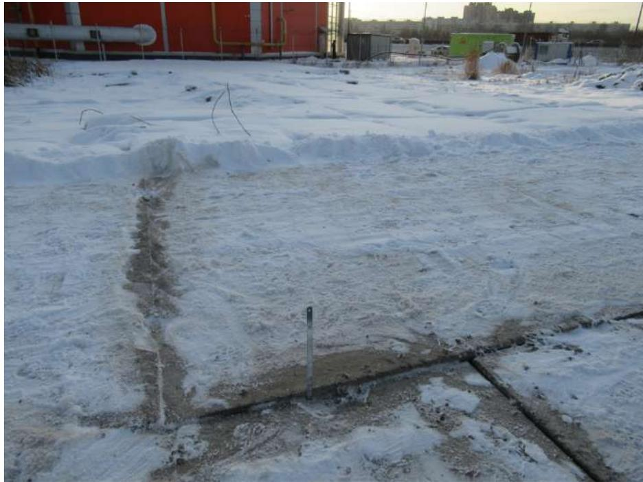
**Фото № 29.** Выполнение контрольных замеров величины превышения граней смежных плит сборных цементобетонных покрытий, уложенных на объекте исследования
