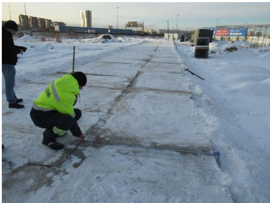
**Фото № 23.** Контроль габаритных размеров сборных цементобетонных покрытий, уложенных на объекте исследования
