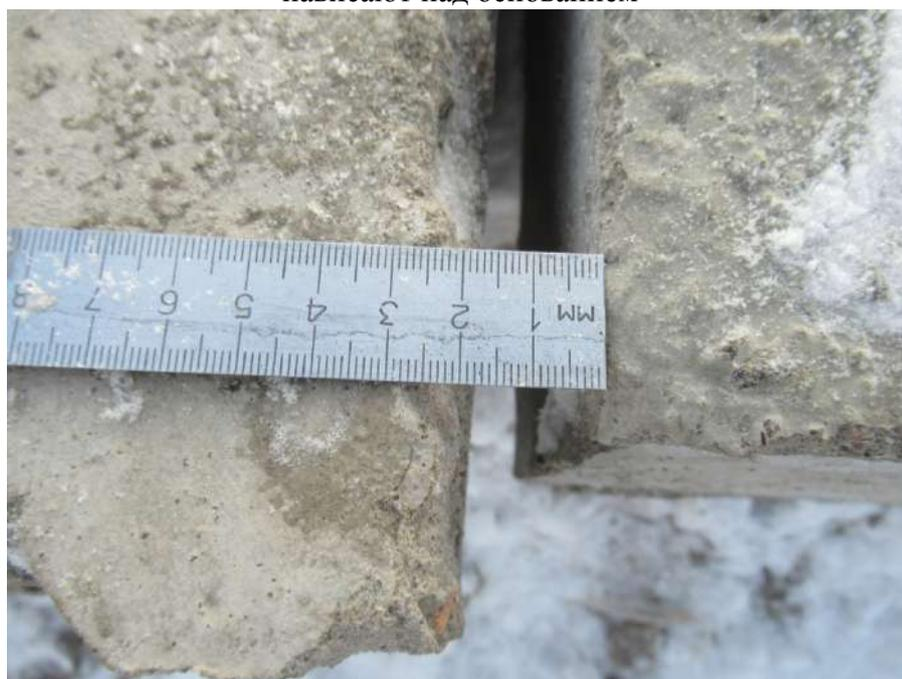
**Фото № 20.** Величина раскрытия поперечного шва в сборных цементобетонных покрытиях, на участке контрольного замера (фото №19), составляет 20 мм
