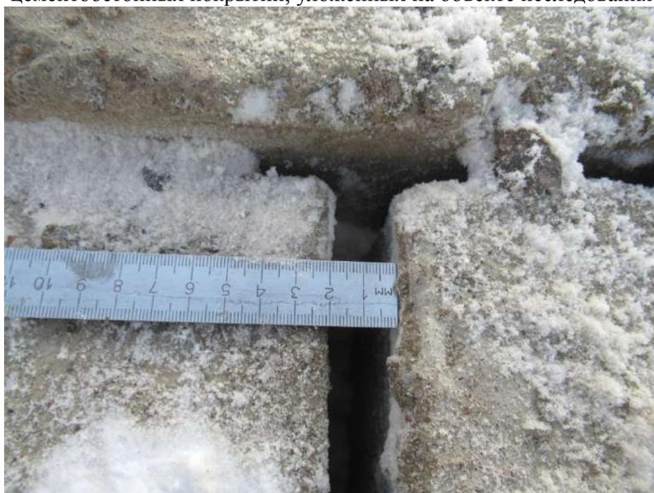
**Фото № 12.** Величина раскрытия шва в сборных цементобетонных покрытиях, на участке контрольного замера (фото №11), составляет 20 мм
