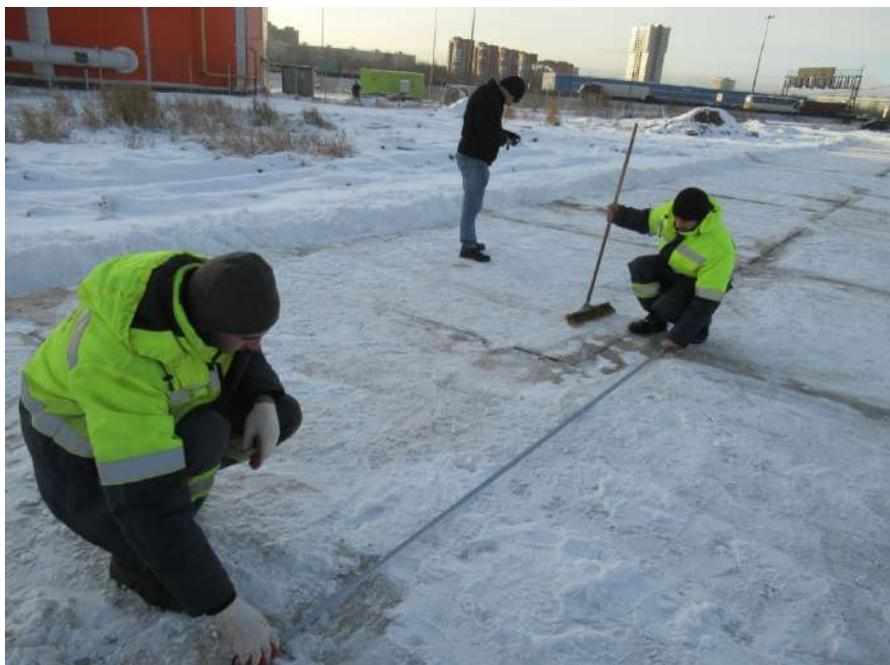
**Фото № 25.** Контроль габаритных размеров сборных цементобетонных покрытий, уложенных на объекте исследования
