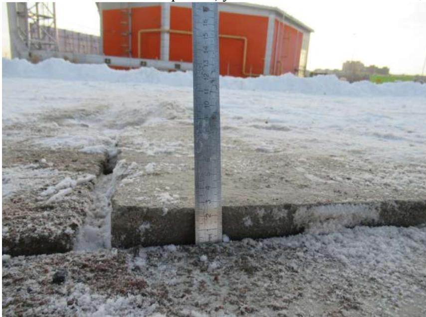
**Фото № 34.** Превышение граней смежных плит сборных цементобетонных покрытий, в месте контрольного замера (фото №33), составляет 26 мм.
