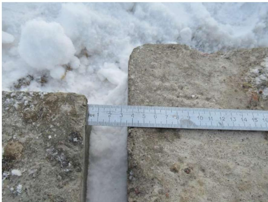
**Фото № 27.** Величина поперечного смещения смежных дорожных плит сборных цементобетонных покрытий, уложенных на объекте исследования (крупный план фото №26), составляет 36 мм.
