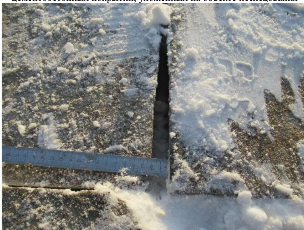
**Фото № 6.** Величина раскрытия шва в сборных цементобетонных покрытиях, на участке контрольного замера (фото №5), составляет 20 мм
