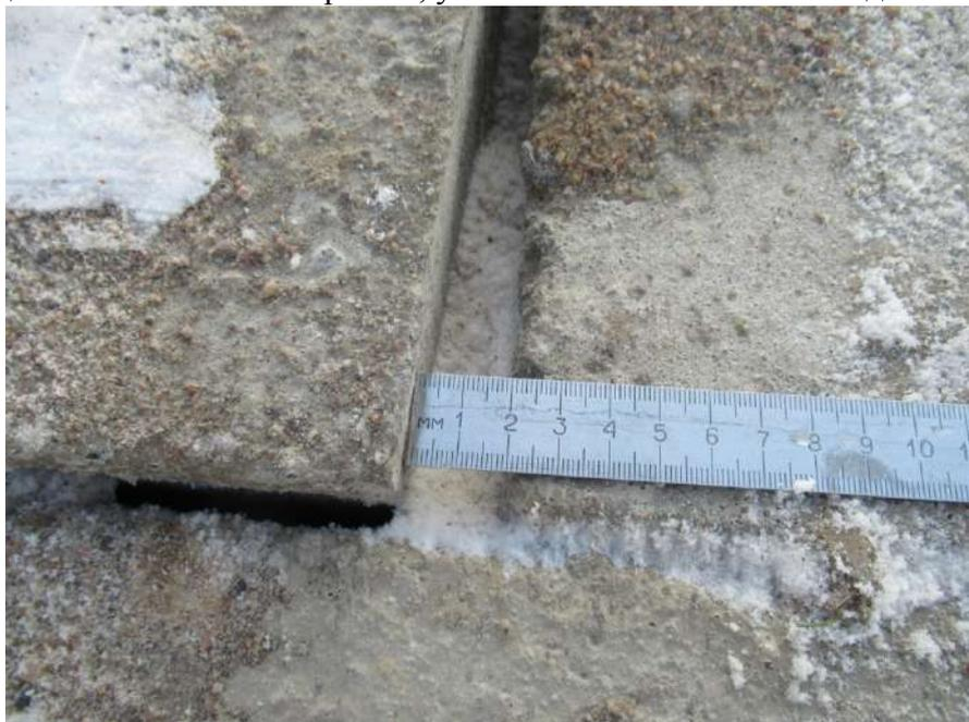
**Фото № 18.** Величина раскрытия шва в сборных цементобетонных покрытиях, на участке контрольного замера (фото №17), составляет 20 мм
