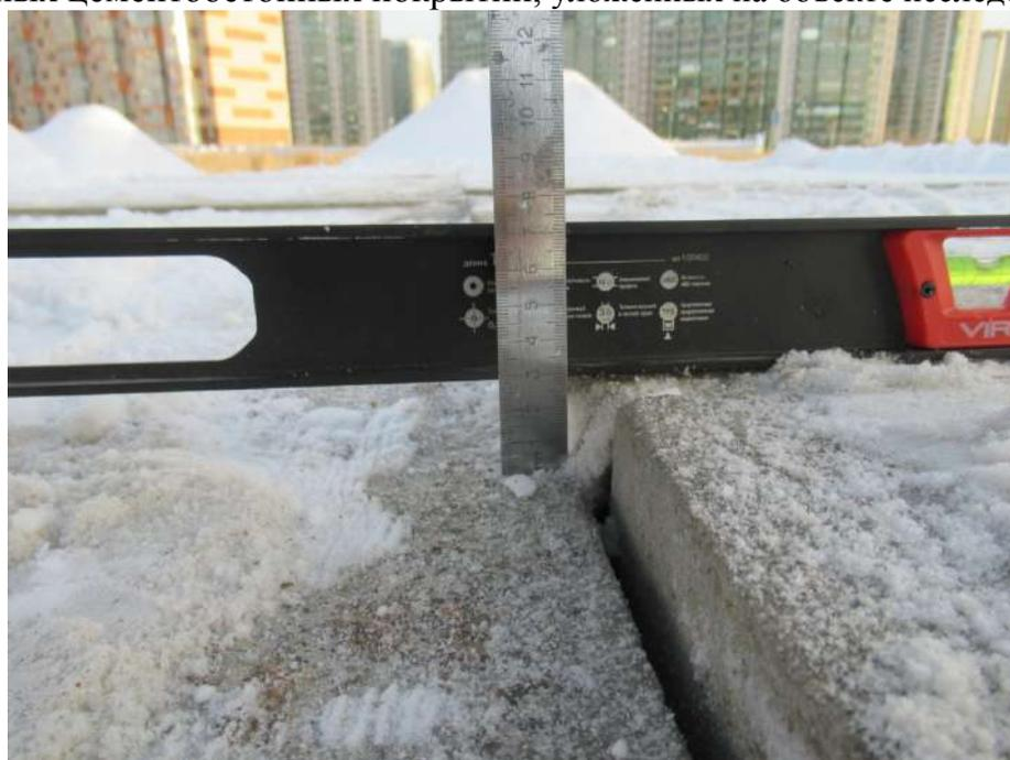
**Фото № 16.** Превышение граней смежных плит сборных цементобетонных покрытий, в месте контрольного замера (фото №15), составляет 29 мм.
