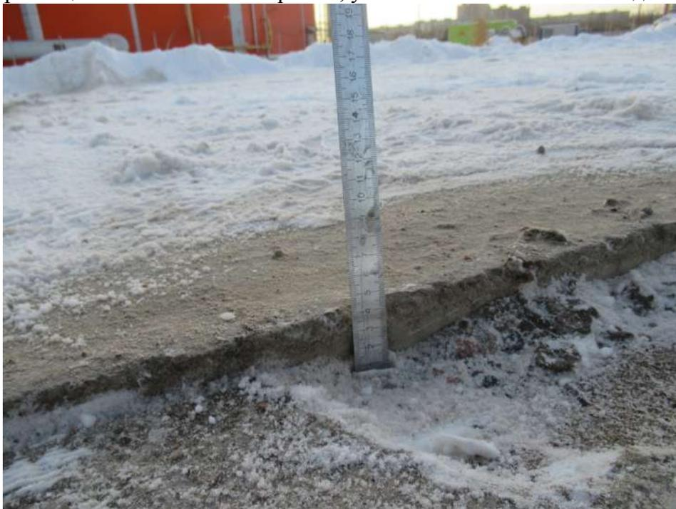
**Фото № 30.** Превышение граней смежных плит сборных цементобетонных покрытий, в месте контрольного замера (фото №29), составляет 45 мм.
