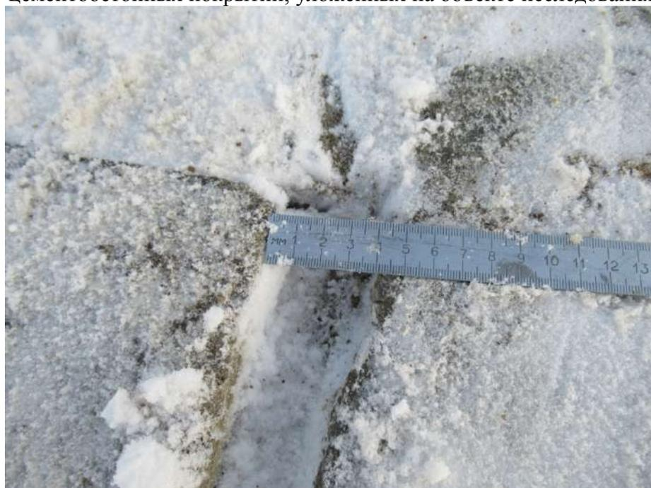
**Фото № 10.** Величина раскрытия шва в сборных цементобетонных покрытий, на участке контрольного замера (фото №9), составляет 40 мм
