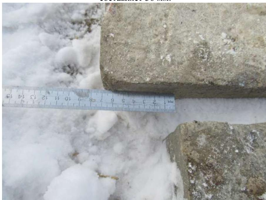
**Фото № 28.** Величина поперечного смещения смежных дорожных плит сборных цементобетонных покрытий, уложенных на объекте исследования (крупный план фото №26), составляет 70 мм.
