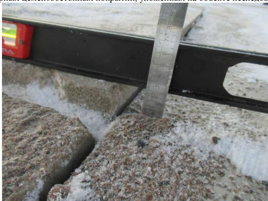
**Фото № 14.** Превышение граней смежных плит сборных цементобетонных покрытий, в месте контрольного замера (фото №13), составляет 26 мм
