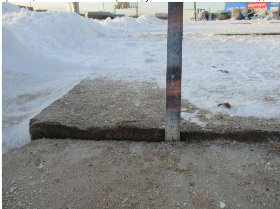
**Фото № 32.** Превышение граней смежных плит сборных цементобетонных покрытий, в месте контрольного замера (фото №31), составляет 15 мм.
