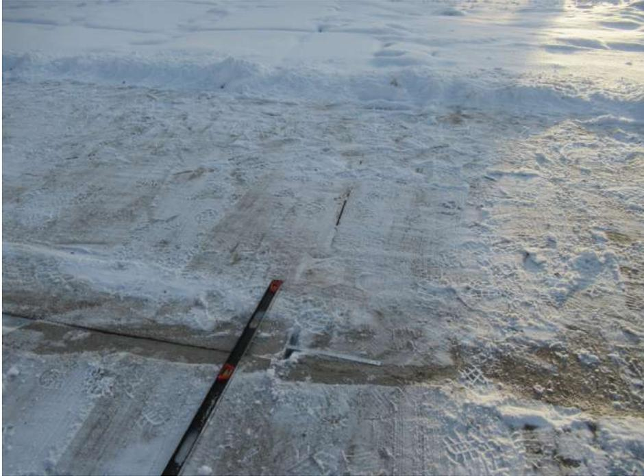
**Фото № 7.** Выполнение контрольных замеров величины раскрытия швов сборных цементобетонных покрытий, уложенных на объекте исследования
