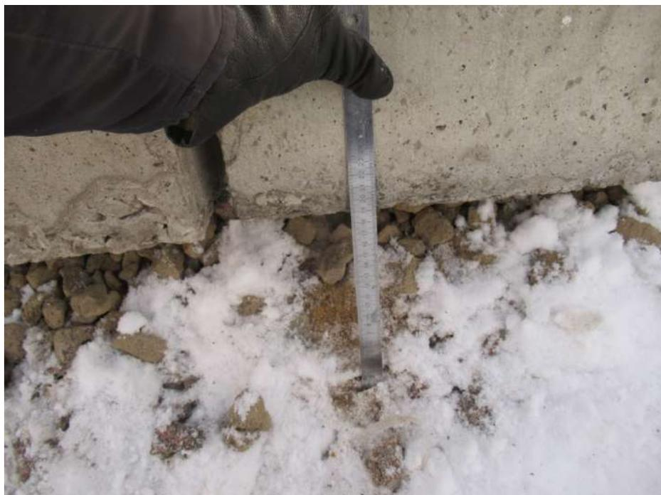
**Фото № 21.** Работы и материалы, примененные при устройстве покрытий из дорожных плит, не соответствуют смете на устройство покрытий из дорожных плит по адресу: Ленинградская область, Всеволожский район, [REDACTED] (Приложению №1 к Договору подряда № 64М-09/19 от 23.09.2019 года). В конструкции дорожной одежды наличие геотекстиля – не выявлено.
