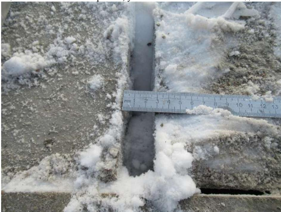
**Фото № 8.** Величина раскрытия шва в сборных цементобетонных покрытий, на участке контрольного замера (фото №7), составляет 28 мм
