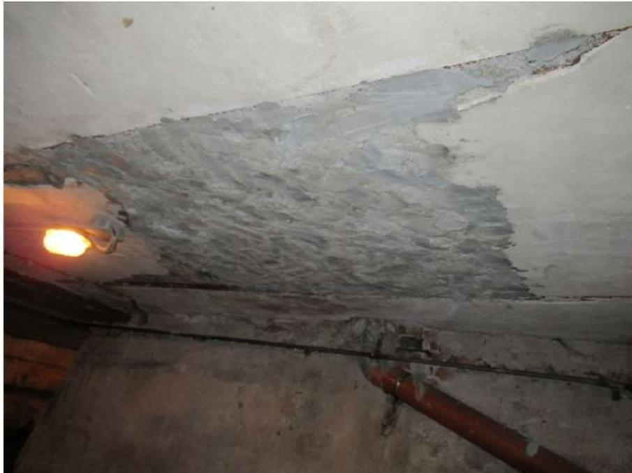
**Фото № 5.** Первый участок перекрытия, на котором при визуальном осмотре объекта исследования были выявлены следы проведения работ по усилению перекрытия подвала.
