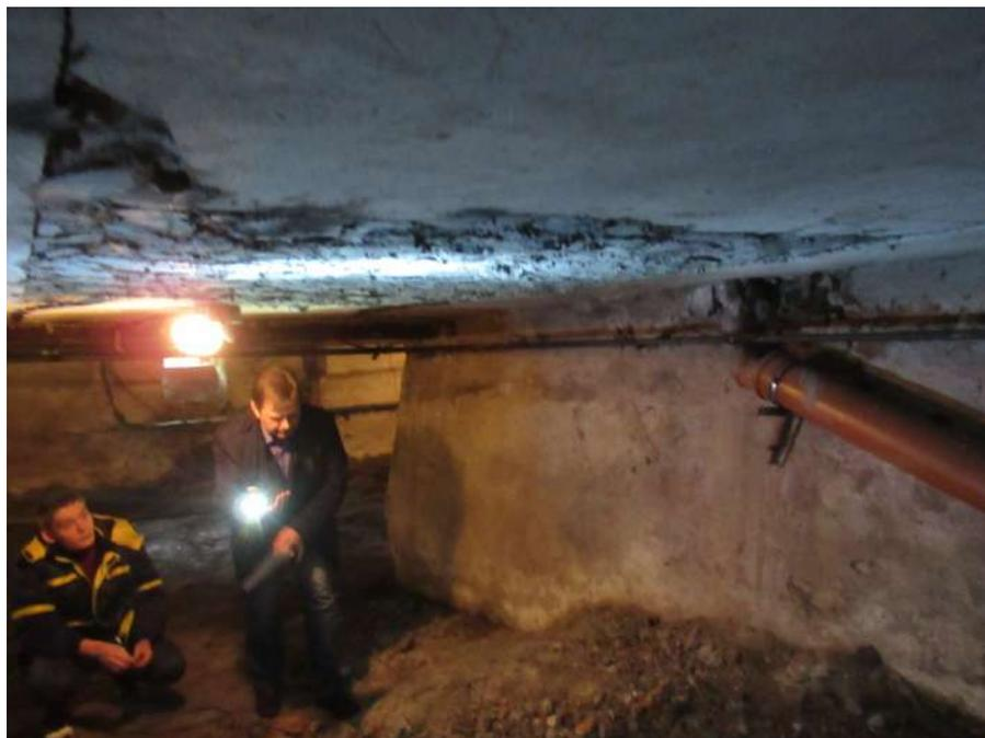
**Фото № 6.** Первый участок перекрытия, на котором при визуальном осмотре объекта исследования были выявлены следы проведения работ по усилению перекрытия подвала.
