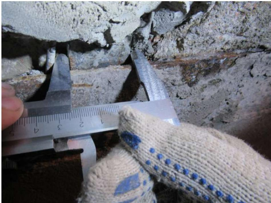
**Фото № 9.** Контрольный замер элементов усиления перекрытия подвала на первом участке ремонтируемого перекрытия исследуемого объекта.
