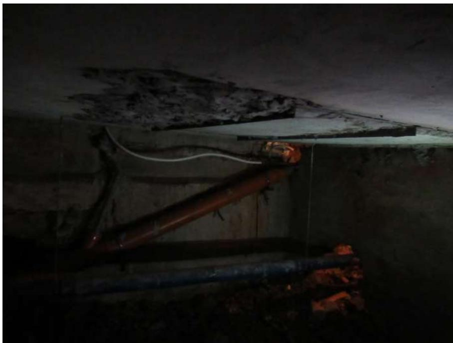
**Фото № 11.** Второй участок перекрытия, на котором при визуальном осмотре объекта исследования были выявлены следы проведения работ по усилению перекрытия подвала.
