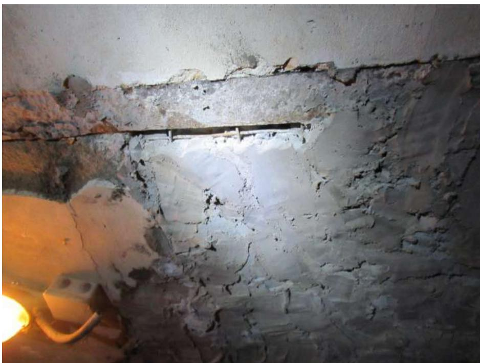
**Фото № 8.** Место контрольного вскрытия конструкции перекрытия на первом участке ремонтируемого перекрытия подвала.
