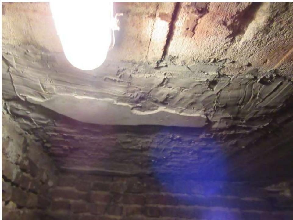
**Фото № 15.** Третий участок перекрытия, на котором при визуальном осмотре объекта исследования были выявлены следы проведения работ по усилению перекрытия подвала.
