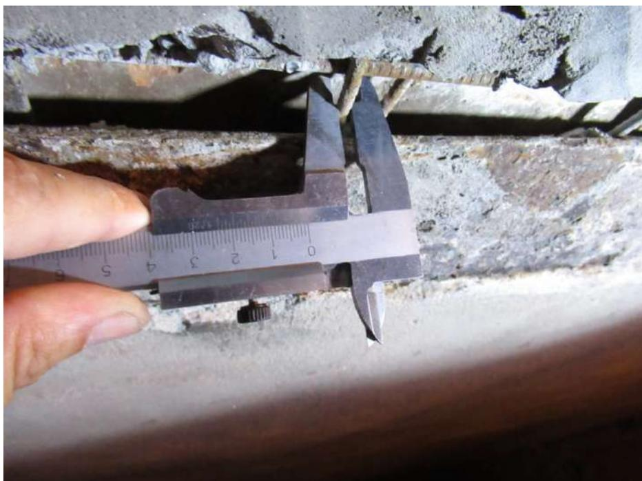
**Фото № 10.** Контрольный замер элементов усиления перекрытия подвала на первом участке ремонтируемого перекрытия исследуемого объекта.
