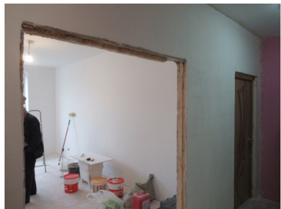
Фото №6 Общий вид на помещения коридора и комнаты кв. № 17
