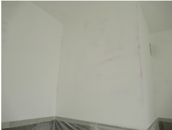
Фото №9 Общий вид стены в помещении кухни кв. 17. На стене видны следы старой краски и непрокрасы.
