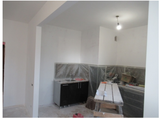
Фото №2 Общий вид на помещение кухни кв. № 17
