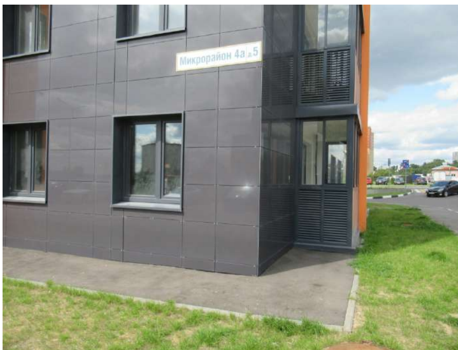
Фото № 2. Общий вид на здание, на котором указан адрес расположения объекта исследования: Микрорайон 4а (д5), со стороны объекта исследования.
