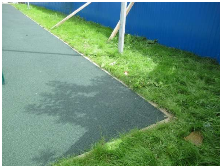
Фото № 43. На газоне виден фрагмент старого резинового покрытия, предположительно демонтированного.
