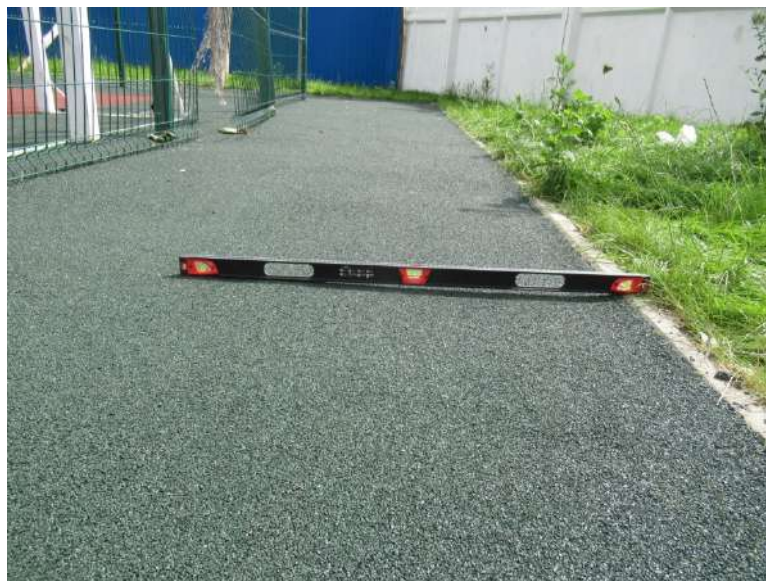
Фото № 31. Спортивная площадка ограничена по периметру бортовыми камнями. Поверхность покрытий спортивной площадки расположена ниже верхней плоскости бортовых камней. Отвод воды с поверхности покрытия – отсутствует.
