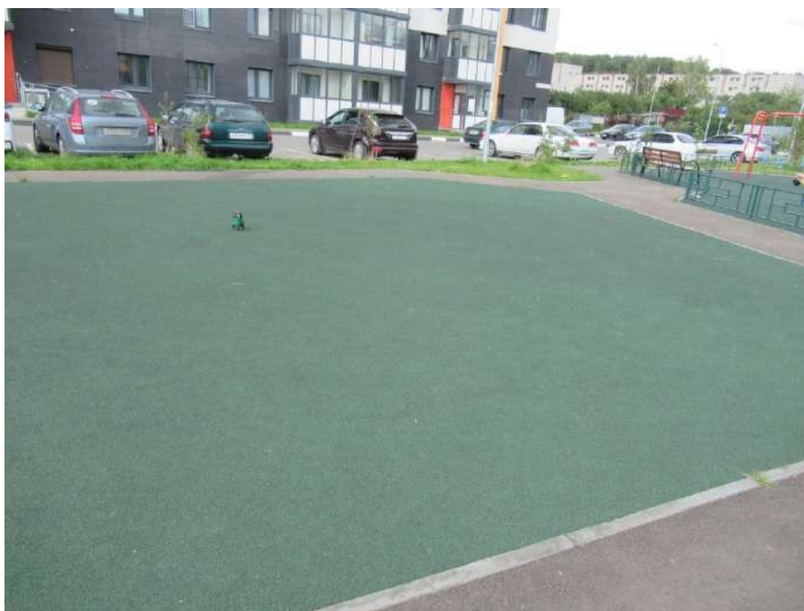
Фото № 11. Состояние универсального покрытия на основе резиновой крошки на площадке без оборудования. Выполнение контрольных измерений лазерным построителем плоскости.
