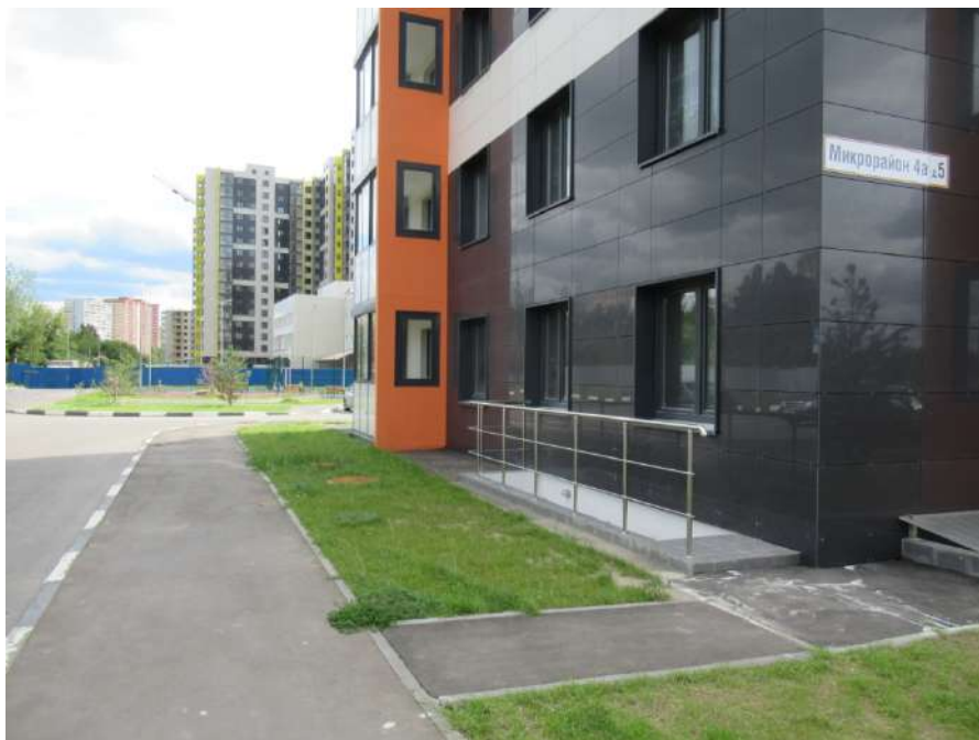
Фото № 1. Обзорный план с видом на здание, на котором указан адрес расположения объекта исследования: Микрорайон 4а (д5). Объект исследования находится за зданием.
