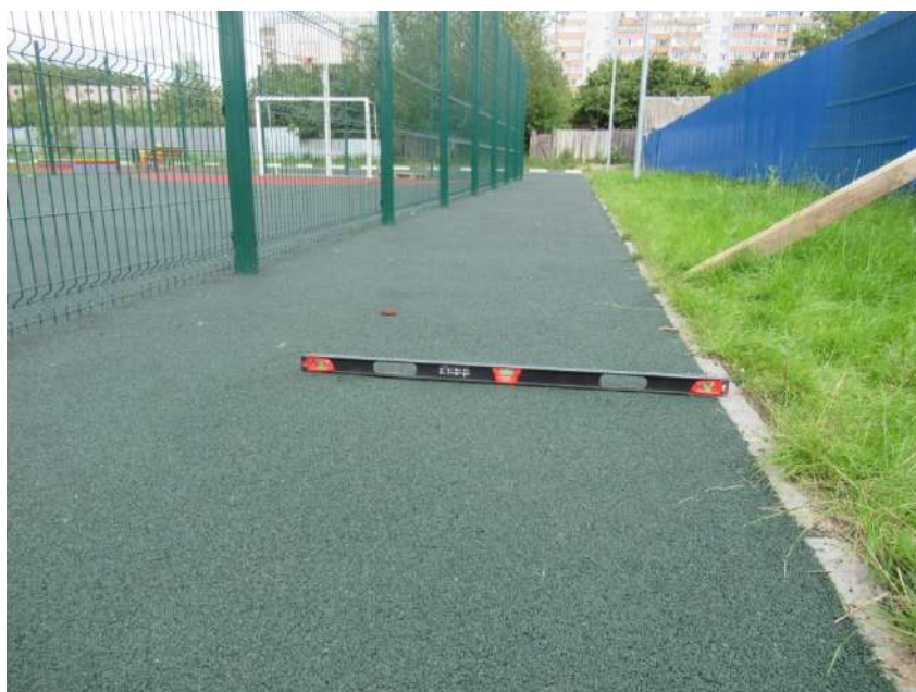
Фото № 31. Спортивная площадка ограничена по периметру бортовыми камнями. Поверхность покрытий спортивной площадки расположена ниже верхней плоскости бортовых камней. Отвод воды с поверхности покрытия – отсутствует.
