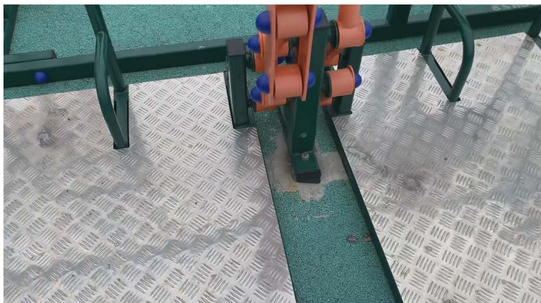
Фото № 26. Крепление опорной конструкция тренажерного комплекса к закладным деталям фундамента смонтированного на площадке №2 у тренажера рули. Места примыкания универсального покрытия к блоку фундамента залиты цементным раствором поверх универсального покрытия, на поверхности универсального покрытия видны темные пятна.
