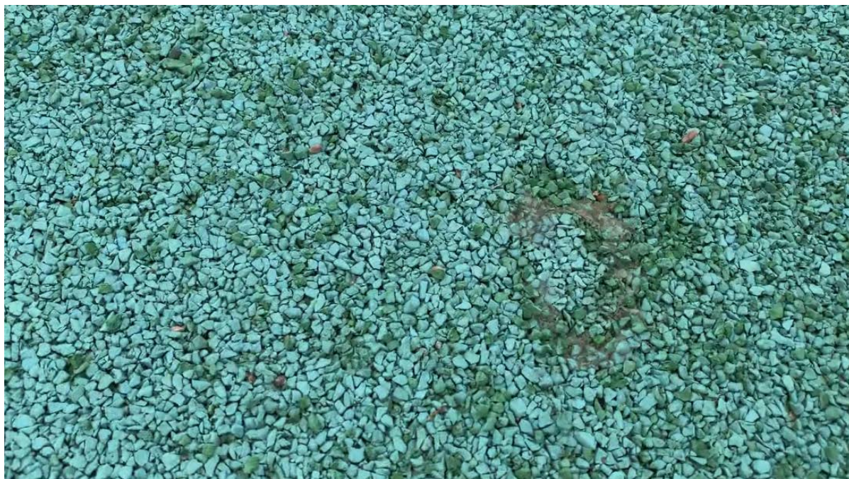
Фото № 27. Следы ремонта универсального покрытия клеящими составами на площадке №1 в центральной части покрытия. Клеящий состав на поврежденном участке №1 нанесен по окружности.
