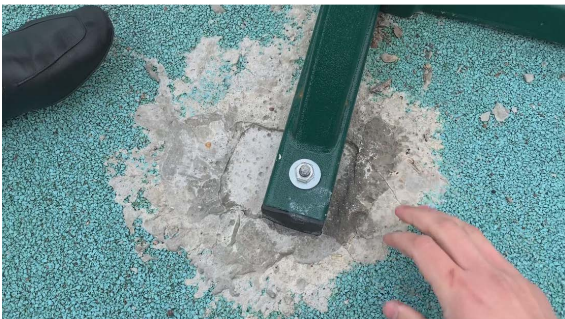
Фото № 22. Крепление опорной конструкция тренажерного комплекса к закладным деталям фундамента смонтированного на площадке №2 у тренажера маятник. Места примыкания универсального покрытия к блоку фундамента залиты цементным раствором поверх универсального покрытия. Видимых мест просадки оснований, деформации или разрывов универсального покрытия в зоне установки фундаментного блока не выявлено.
