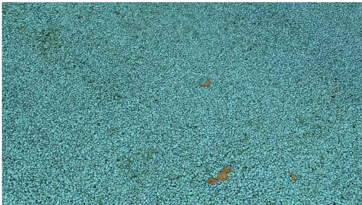
Фото № 15. Участок универсального покрытия на площадке №2 в центре. На поверхности универсального покрытия видны следы монтажной пены.
