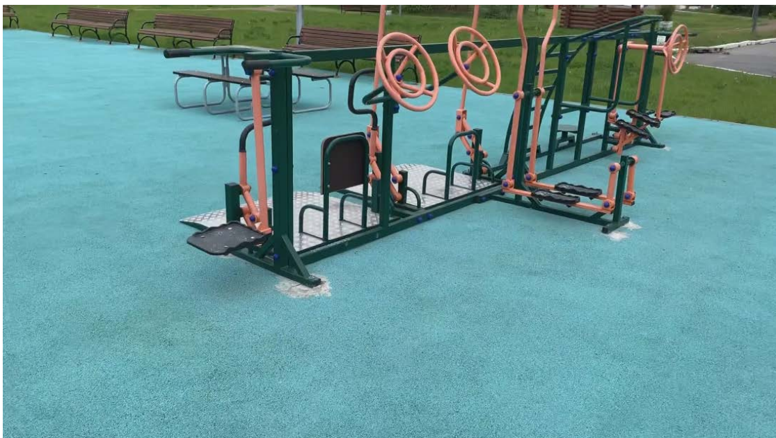
Фото № 21. Общий вид тренажерного комплекса смонтированного на универсальном покрытии на основе резиновой крошки на площадке №2.
