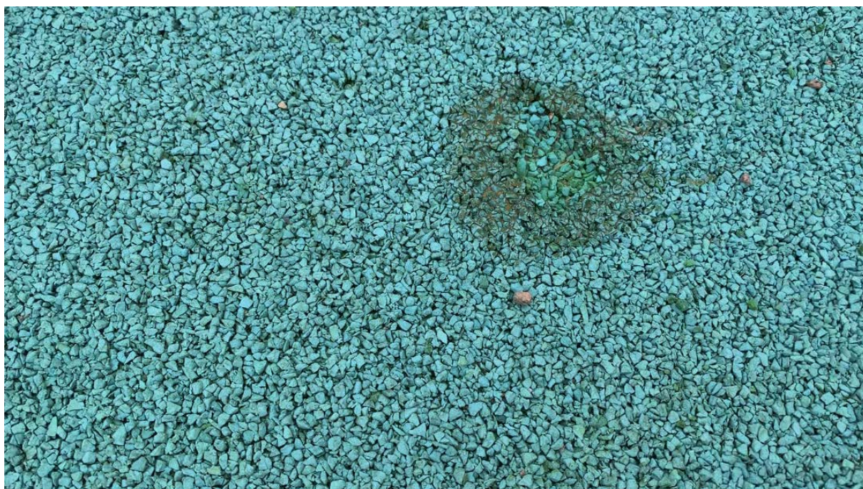
Фото № 30. Следы ремонта универсального покрытия клеящими составами на площадке №2 в центральной части покрытия. Следы повреждения универсального покрытия имеют дугообразную форму, клеящий состав на поврежденном участке №1 нанесен по кругу.
