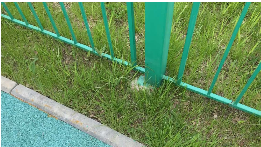
Фото № 7. Участок примыкания универсального покрытия к бортовым камням на площадке №1 у секций металлического ограждения. Зазор между бортовым камнем и резиновым покрытием заполнен строительной монтажной пеной, следы монтажной пены и клеящих составов видны на бортовых камнях и на поверхности универсального покрытия.
